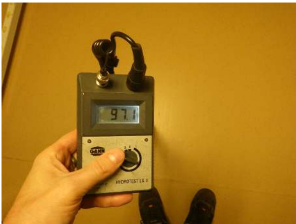
5. Pintakosteusmittarilla tehtyjä poikkeavia havaintoja uusimman osan lattiarakenteesta.
