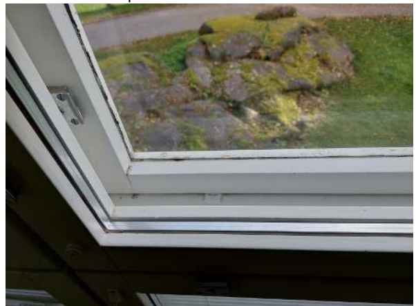
68. Ikkunat ovat MSE -tyyppiset. Ulkopinta on puurakenteinen.
