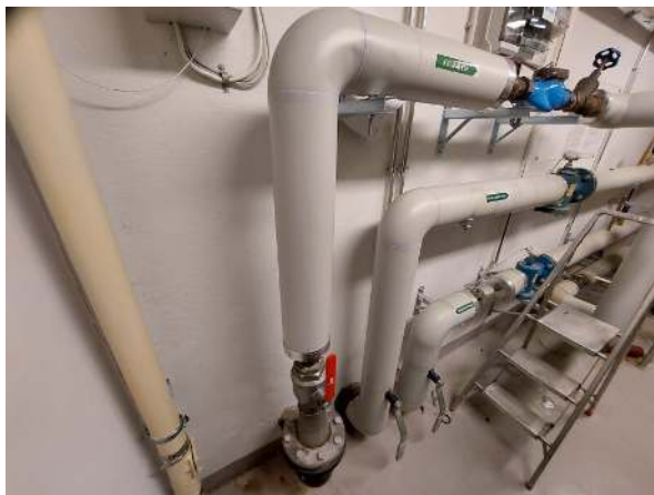
141. Kiinteistön vesimittari.
