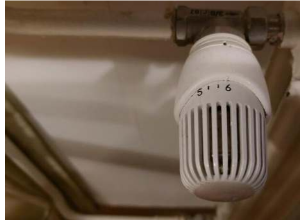
138. Patteriventtiilit termostaattiventtiilejä.
