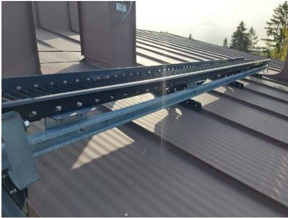
99. Vesikattovarusteet ovat kunnossa.
