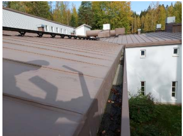
102. Vesikaton vedenpoistojärjestelmä.
