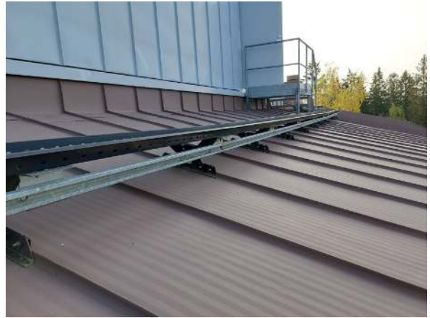
100. Vesikattovarusteet ovat kunnossa.
