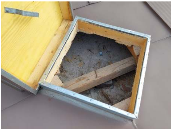
103. Tarkastusluukku yläpohjaan.
