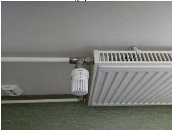
139. Patteri ja patteriventtiili.
