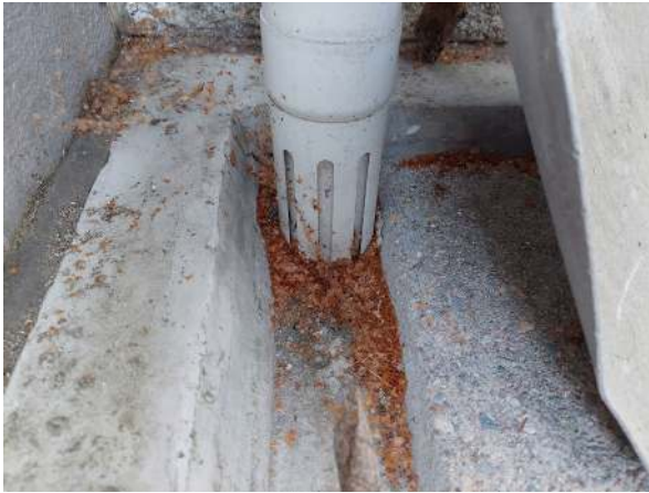
84. Parvekkeiden vedenpoistojärjestelmää.
