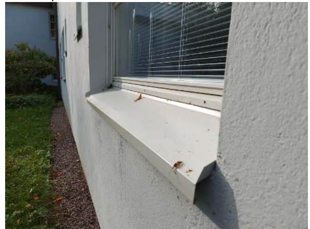
72. Vesipeltien kallistukset ovat kunnossa.
