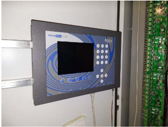
159. Valvontakeskuksen käyttöpaneeli.
