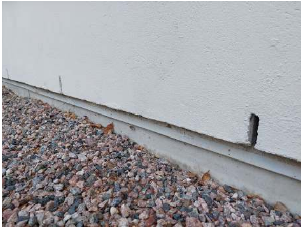
53. Tiiliverhouksen tuuletusrakojä.
